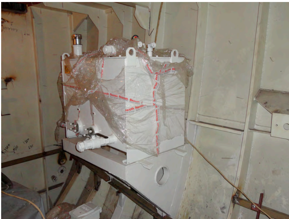
Машинное отделение – гидростанция рулевого управления
