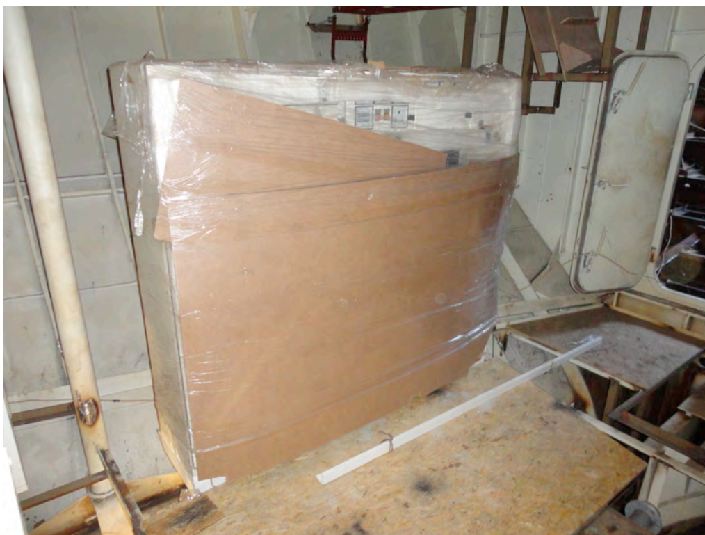
Машинное отделение – главный распределительный щит
