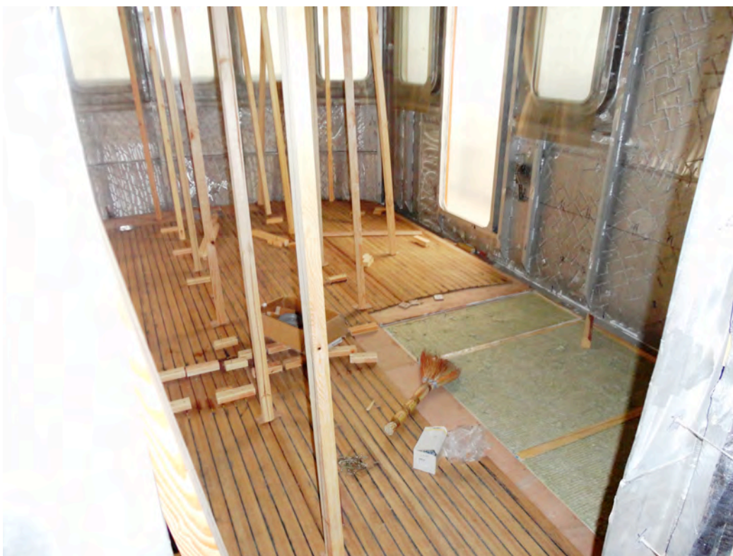
Помещение ходового мостика – монтаж палубного покрытия по уложенной изоляции плавающего пола
