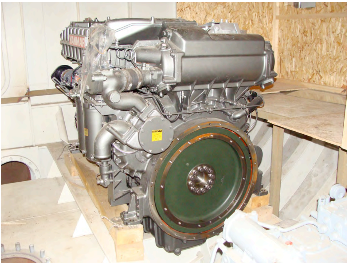
Машинное отделение – вид на установленные дизельные генераторы и главный двигатель перед центровкой
